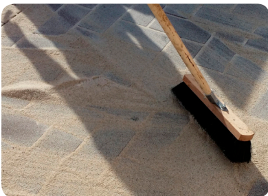
Nachsanden, nochmals abrütteln und rückstandsfrei abfeigen
